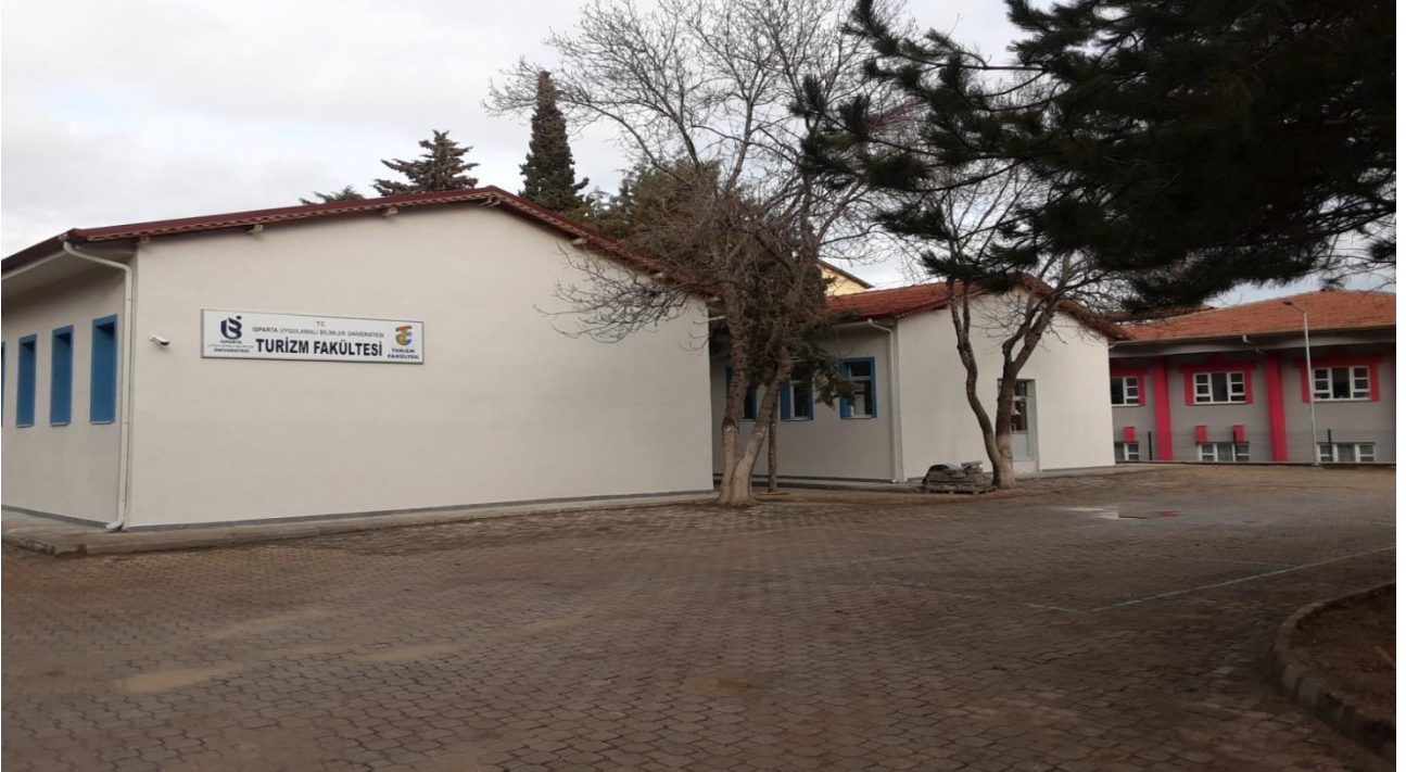
Atölye Binaları Son Hali
