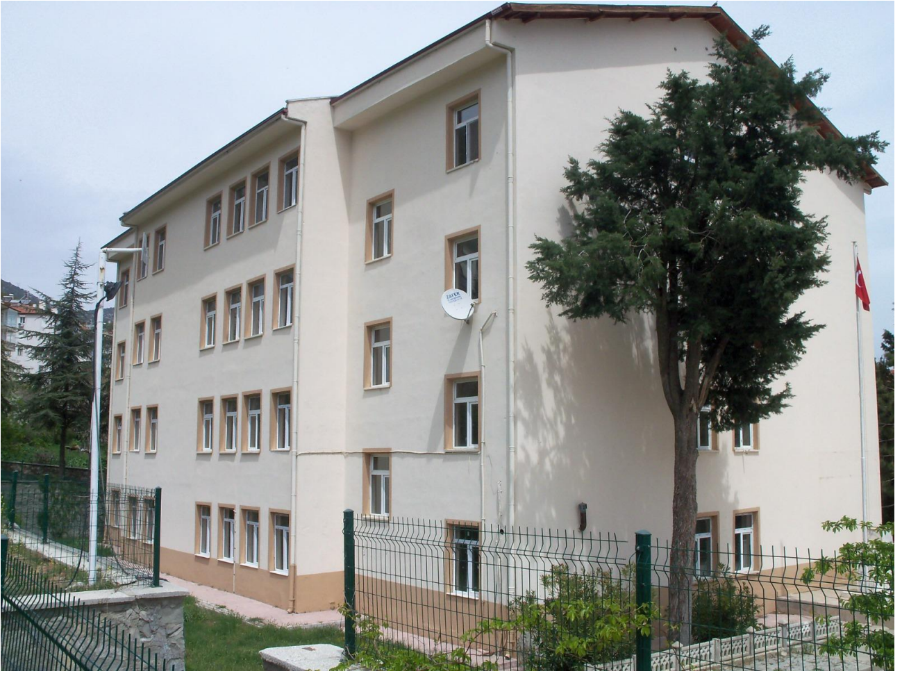
Eski Hali Arka Cephe
